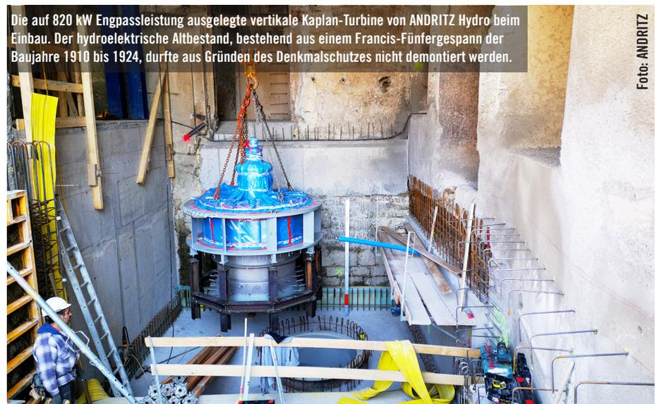
Die auf 820 kW Engpassleistung ausgelegte vertikale Kaplan-Turbine von ANDRITZ Hydro beim Einbau. Der hydroelektrische Altbestand, bestehend aus einem Francis-Fünfergespann der Baujahre 1910 bis 1924, durfte aus Gründen des Denkmalschutzes nicht demontiert werden.
